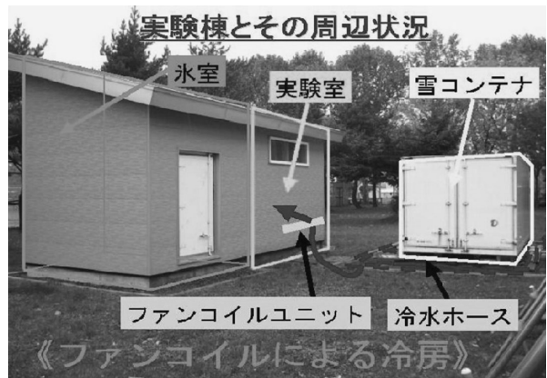
図Ⅳ-4 ファンコイルによる冷房の概要
