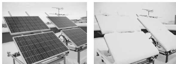
図Ⅲ-1 太陽光モジュール(右は積雪時)
