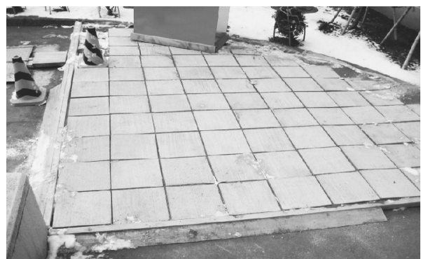
図V-6 コンクリート平板敷設
