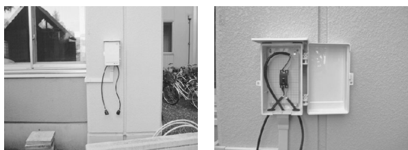
図Ⅲ-7 外壁に取り付けたコンセント
