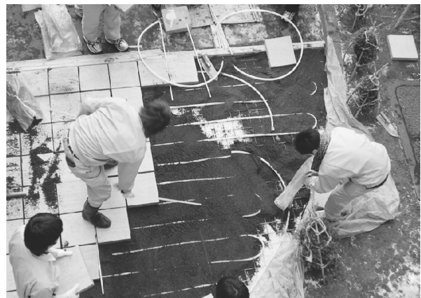
図V-5 生徒による配管設置作業
