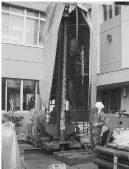
図V-2 地下水を掘り出す工事
