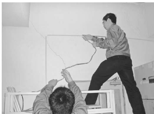
図Ⅲ-8 配線の様子（上：天井裏 下：壁面）
